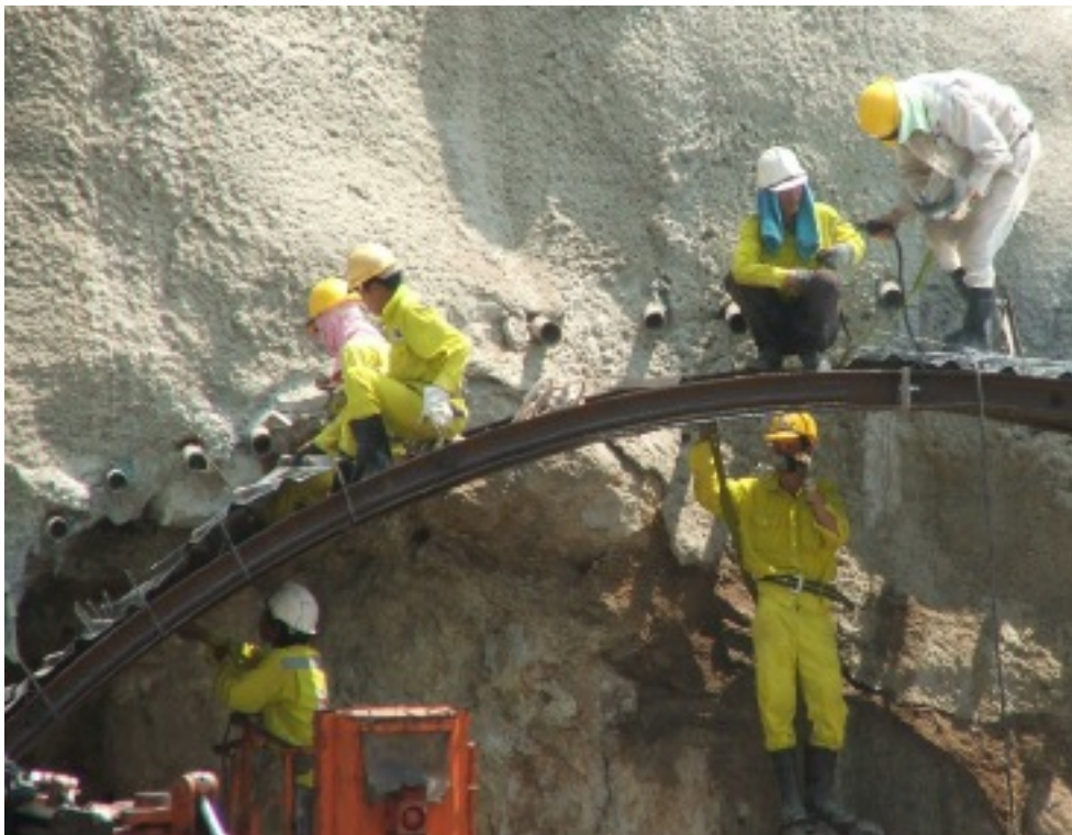
Các công nhân đang thi công trước miệng hầm Đèo
